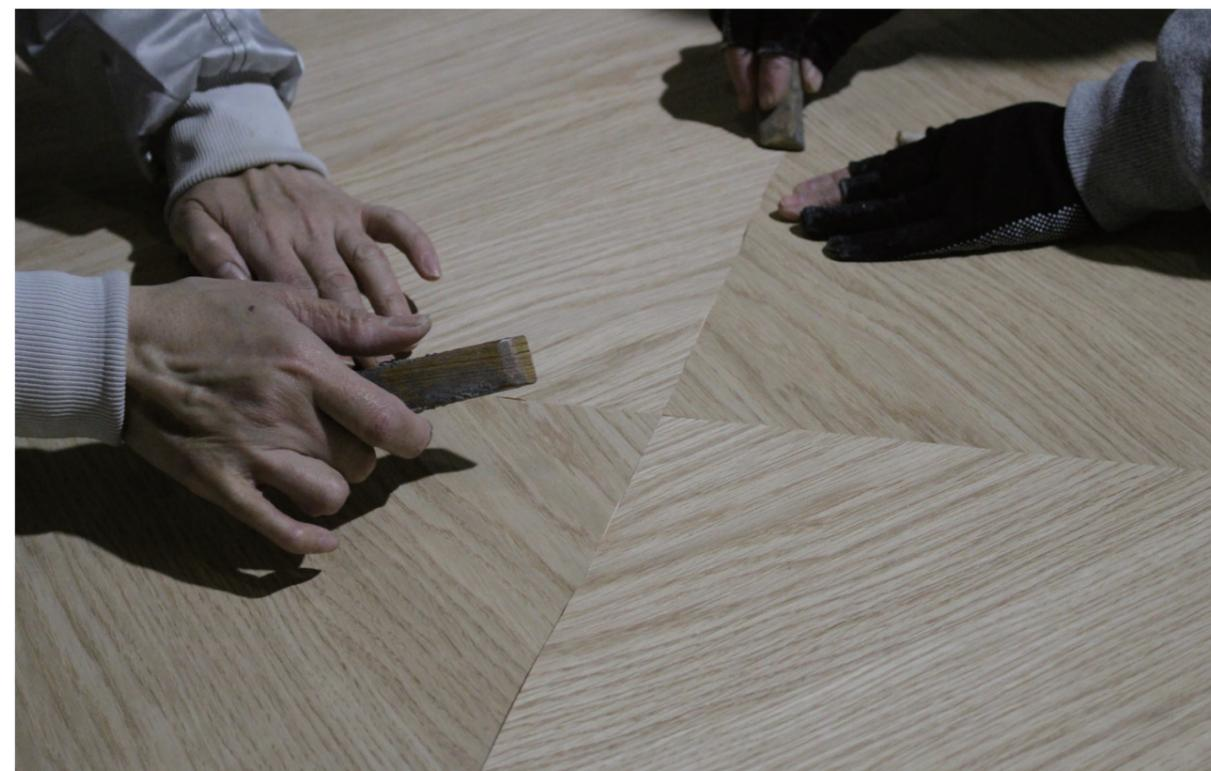
**ダイヤモンド貼り** ダイヤモンド貼りは、ツキ板をダイヤモンドの形状に配置して貼り付けるデザイン手法です。隣り合う板が斜めに配置されることで、ダイヤモンド状の模様が生れます。同じロットのツキ板を使用していますが、木の向きによって変わる僅かな杢目の凹凸の違いが色味に変化をもたらします。
